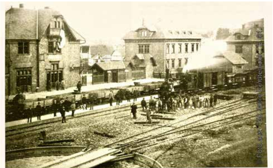
Der Bahnhof Erndtebrück kurz vor der Eröffnung. Gebäude und Nebengebäude stehen bereits, an den Gleisen finden letzte Bauarbeiten statt. Wie damals üblich haben die Beteiligten für den Fotografen Aufstellung bezogen.
